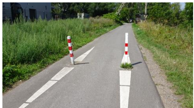
Abbildung 31: Sicherheitsrisiko durch Poller (links: Sanssouci, Balve) und markierte Poller mit reduziertem Risiko (rechts: Bild nicht aus dem Sorpeland)
