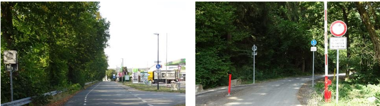
Abbildung 19: Gehweg, Rad frei und Schutzstreifen (links: Heinrich-Lübke-Straße, Arnsberg); eigenständiger Geh-/Radweg (rechts: Sundern)
