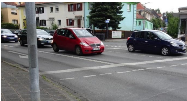
Abbildung 29: Fehlender Aufstellbereich an einer Kreuzung (links) und markierter Aufstellbereich (rechts) (Hinweis: Bilder nicht aus dem Sorepeland)
